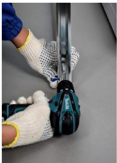
**8. СОЕДИНЯЕМ С СТЕНОВЫМ ПРОФИЛЕМ**
